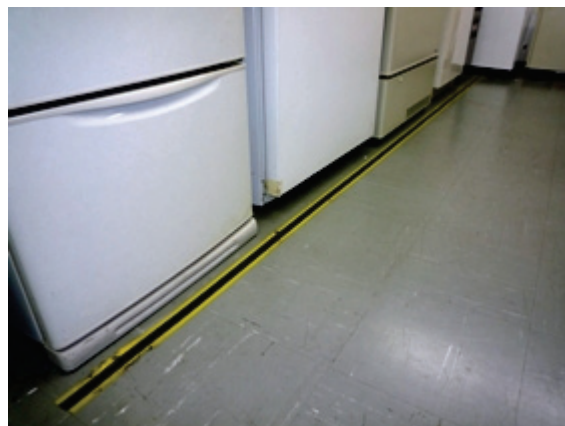
図6 前面床の安全標示テープ
