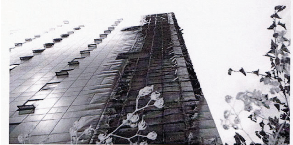
写真4 韓国ハジンビルの被害状況(ソウル市立大学 尹 教授提供)
